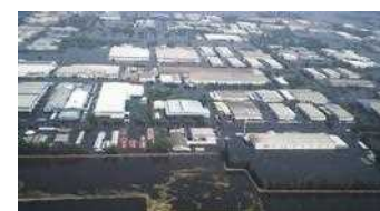
タイロジャナ工業団地の浸水状況 (2011年10月～11月)
