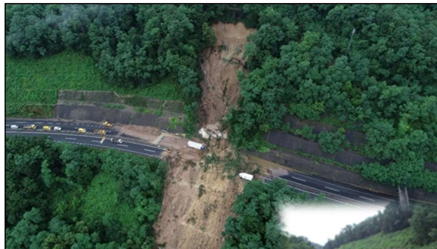
⑧東北道 大規模切土のり面崩落
