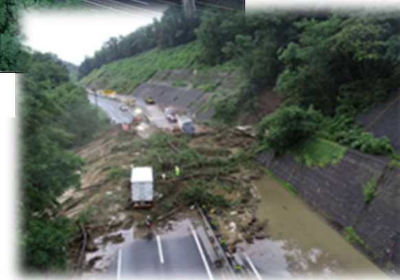
⑧東北道 大規模切土のり面崩落
